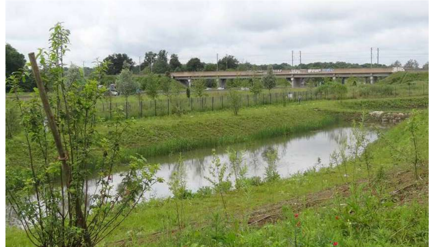
▼ fig. 26 // Exemple de bassin planté - photo : ©PAYET
